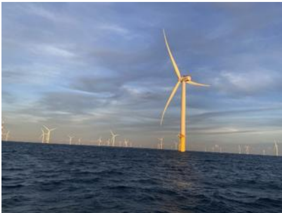
台湾の洋上風力発電施設
