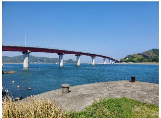
写真 1 受信機を移動した先の宇佐大橋前
